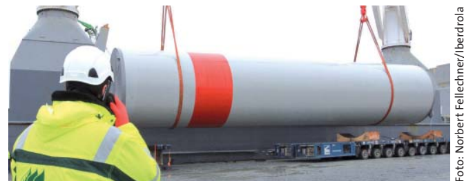
Verladung eines Turmsegments im Mukran Port
